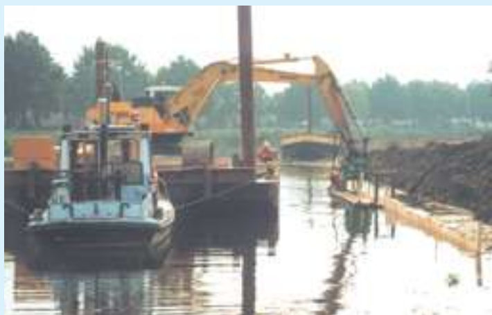
De aanleg van een milieuvriendelijke oever in Scheemda, september 2000.
